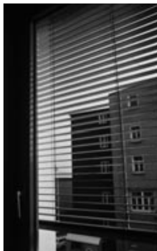
写真3 外側ブラインドの例。左下にスラット角と上げ下げを調整するハンドルが見える。
