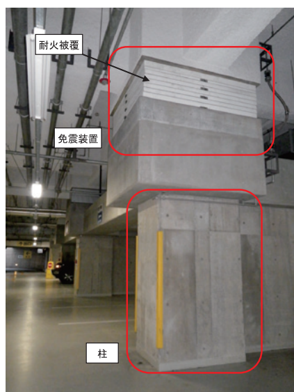
図1 免震装置の設置方法
