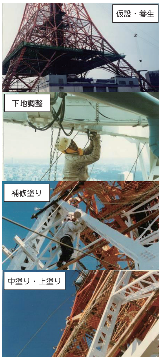
写真5 塗替塗装作業の状況
