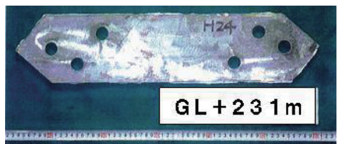
写真4 塗膜除去後の鋼材表面状況
