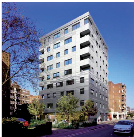
写真2 イギリスの木造9階建て集合住宅 2) (資料：KLM Massivholz社)
