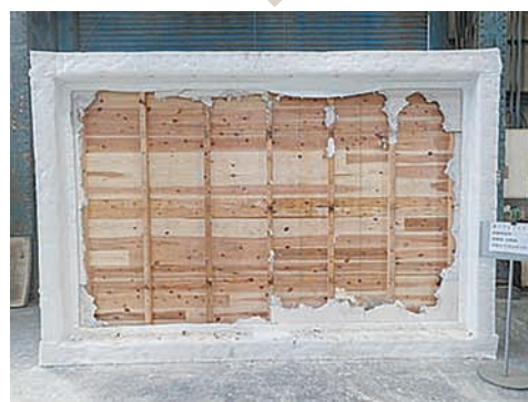
CLTが健全な状態であることを確認
