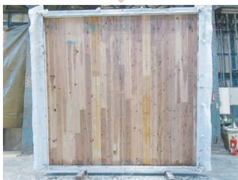
CLTが健全な状態であることを確認
