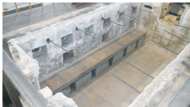
写真3 はり炉(床および屋根の試験対応)
