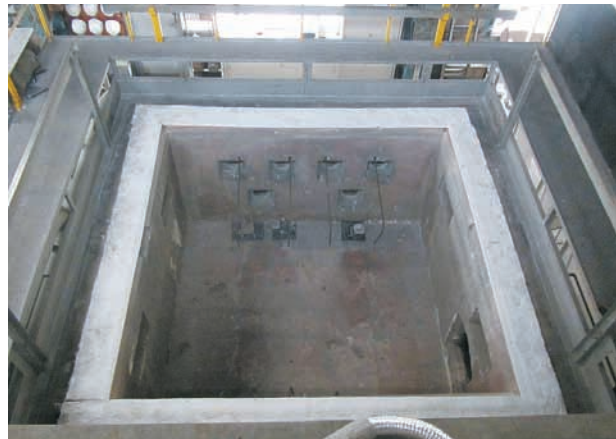
写真2 水平炉(床、屋根および階段の試験対応)
