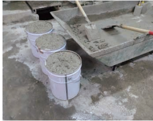
写真2 フレッシュコンクリートの分取状況
