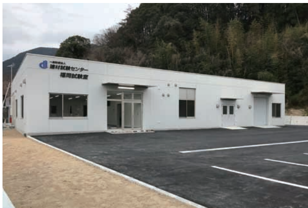
写真1 福岡試験室全景
