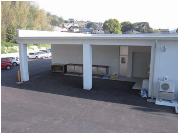
写真2 荷捌き所(供試体搬入場所)
