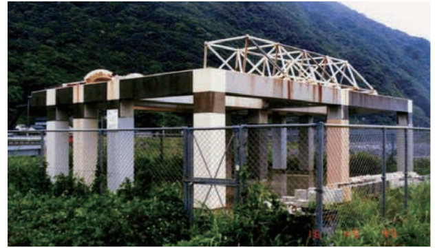
写真4 沖縄における柱・梁部材の補修材料・工法の耐久性評価に関する暴露試験(約25年経過)
