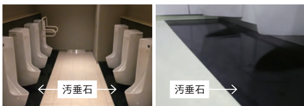
写真1 汚垂石の使用状況の一例
