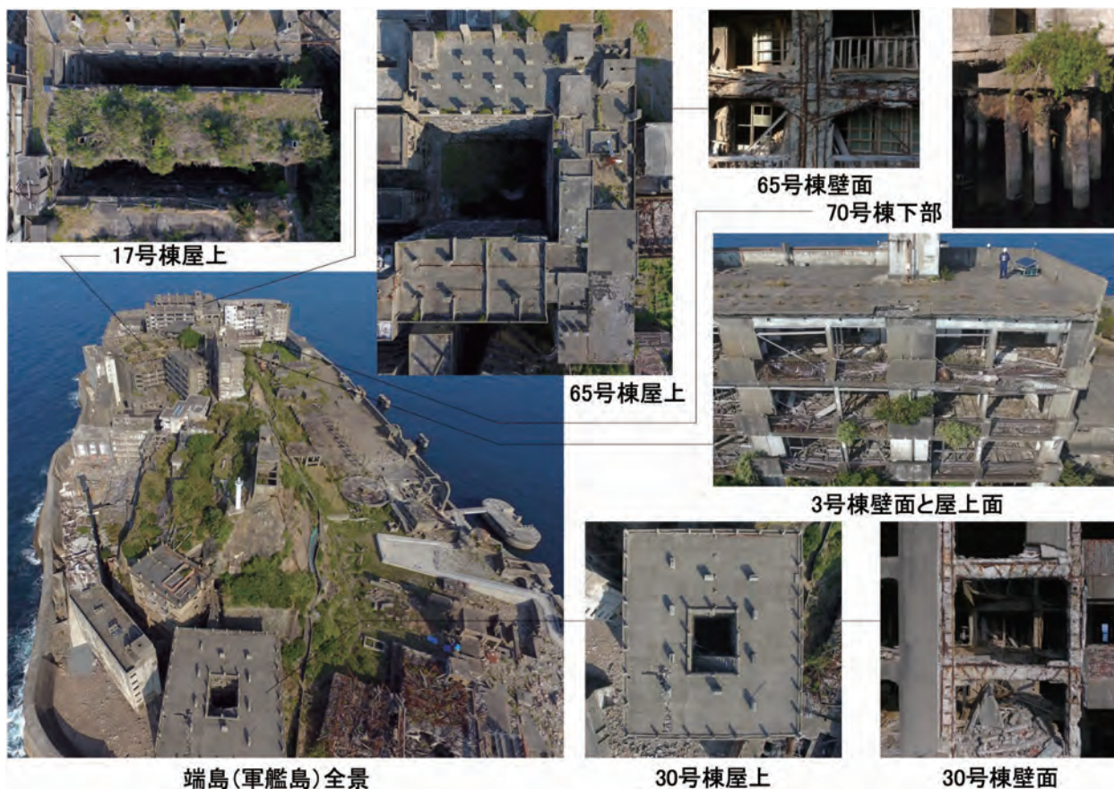
写真1 ドローンで撮影した端島（軍艦島）の状況（2016年12月時点）
