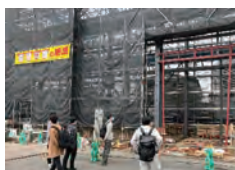
新防耐火試験棟工事
