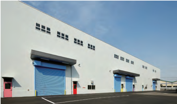
写真1 新試験棟の中央から北側
