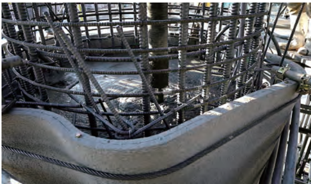
写真6 プリント型枠へのコンクリート打込み
