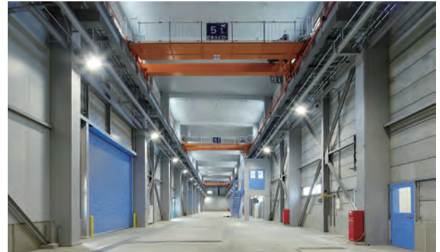
写真2 新試験棟の内部(北側からの全景)
