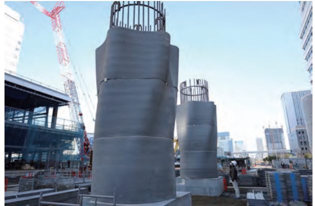
写真7 コンクリート打込み直後の柱部材
