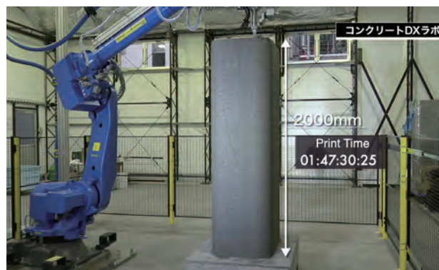
写真2 高さ2m積層体のプリンティング状況
