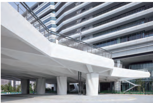
写真8 デッキ施工後の全景
