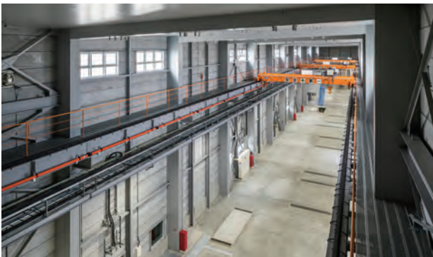
写真3 新試験棟の内部(キャットウォークからの全景)
