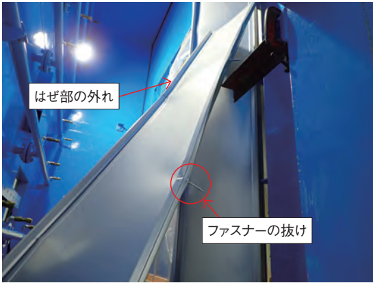
写真6 破壊状況(試験体2)
