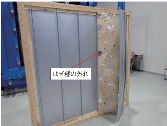
写真7 破壊状況(試験体3)
