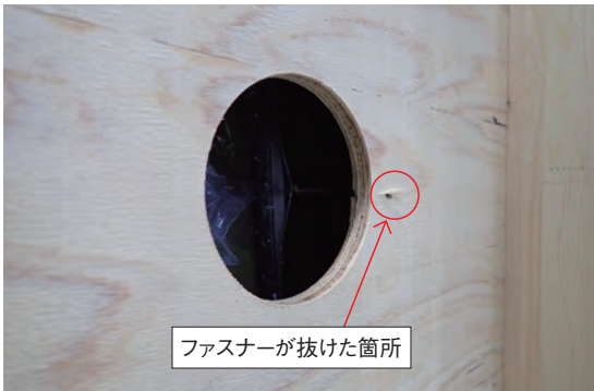
写真5 破壊状況(試験体1)
