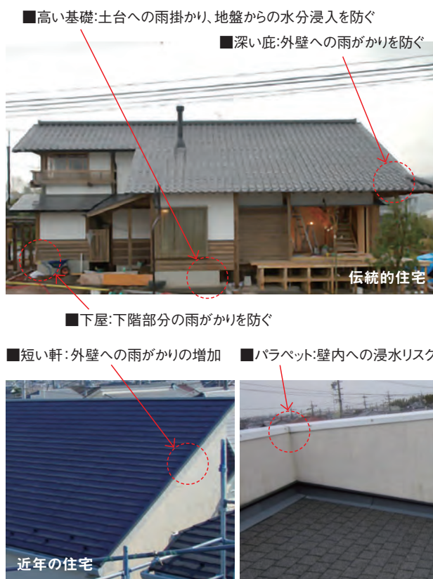
図1 木造住宅の意匠による雨がかりへの影響
