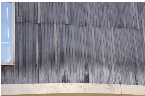
写真1 10年程度経過した木質の外装材
