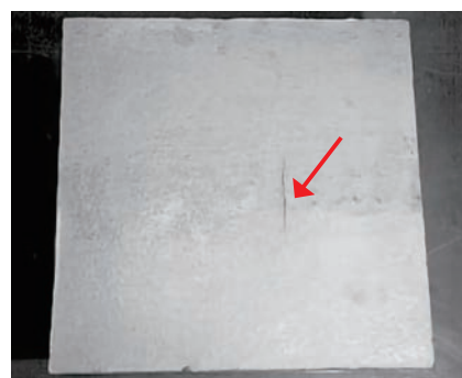
ひび割れ発生
