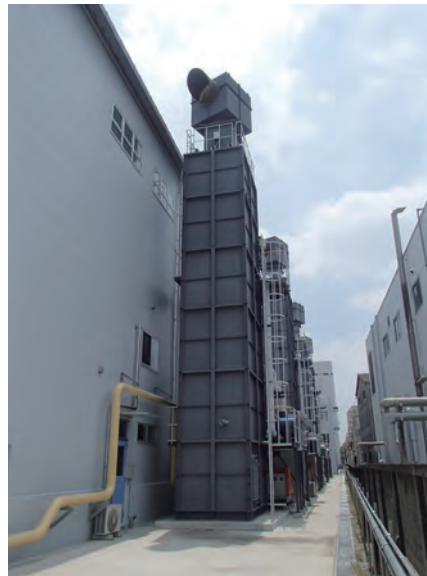
写真11 脱煙脱臭炉
