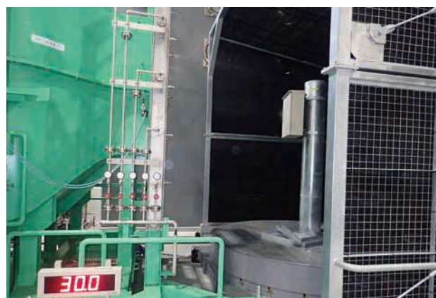
写真4 キャビネットの送風散水試験
