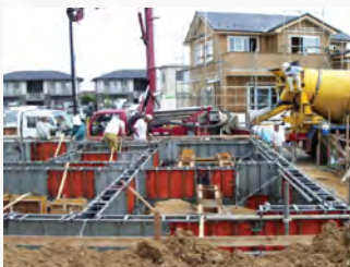
コンクリート打設現場での供試体採取
