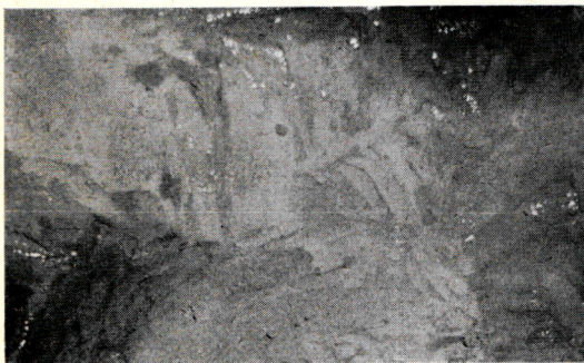
⑦ブリキ板，前処理，材令4日後
