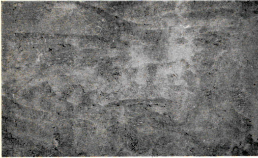
③石綿スレート平板，処理なし，モルタル塗施工後24時間
