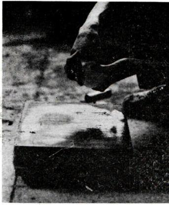
⑬ モルタル塗工前のコンクリート面露吹き
