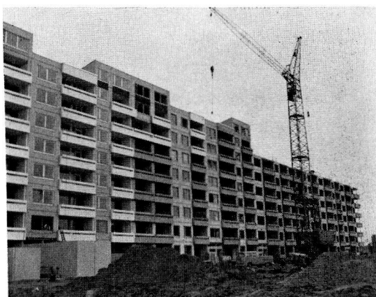
写真10 ハンブルグ近郊、モンタージュバウ方式のプレハブアパート建設中
