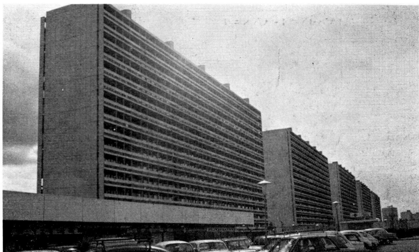
写真8 コペンハーゲン郊外にて, Jespersen 方式の高層プレハブアパート
