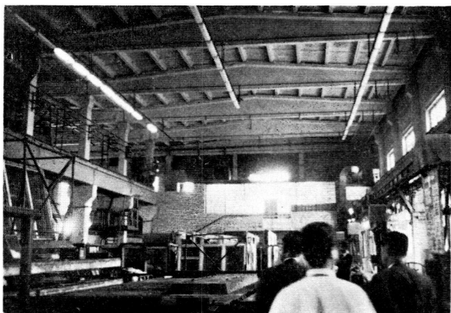
写真3 レニングラードのプレハブ工場
