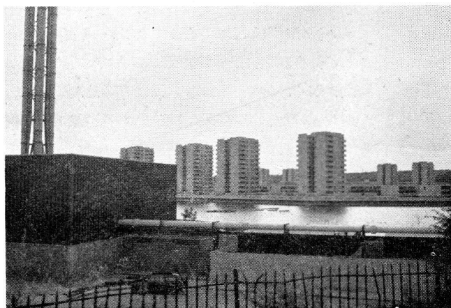
写真28 テームズミード、竣工アパート群
