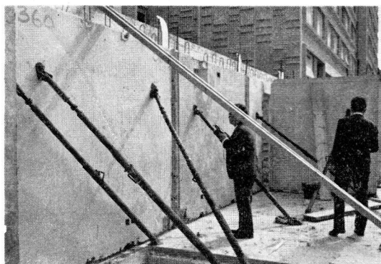
写真26 バイソンシステム建方中
