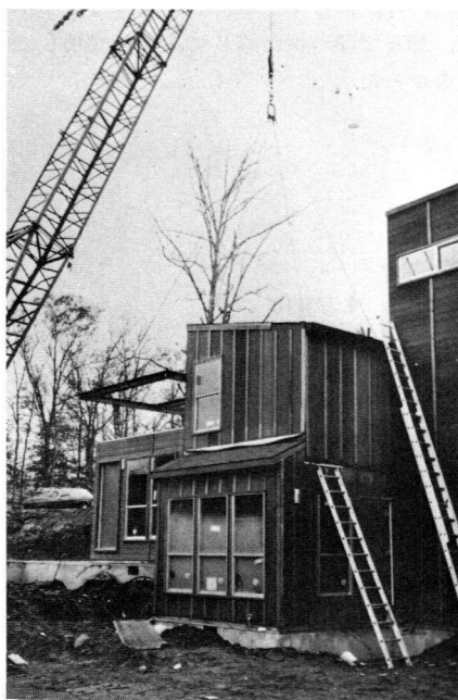
▲写真9 ハーキュリーズ社の建設現場
