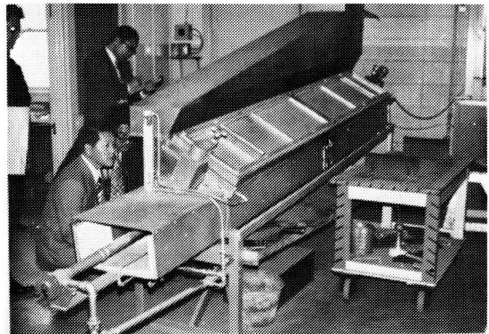
写真16 Flame Spread test装置
