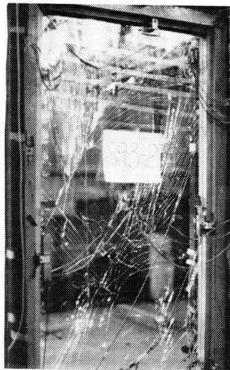
図-7 ガラス破壊状況 (S93-2)。
