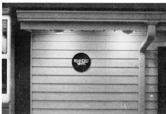
写真14 プラスチック(PVC)外壁
