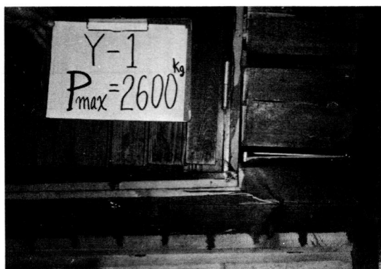
写真-6 破壊状況
