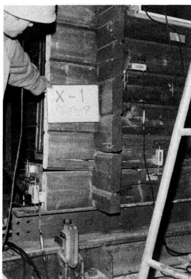
写真-1 破壊状況
