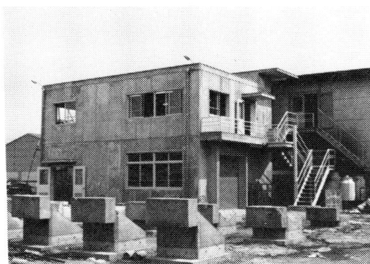
写真-1 第4棟の外観 (シャッターが試験体の搬入口)
