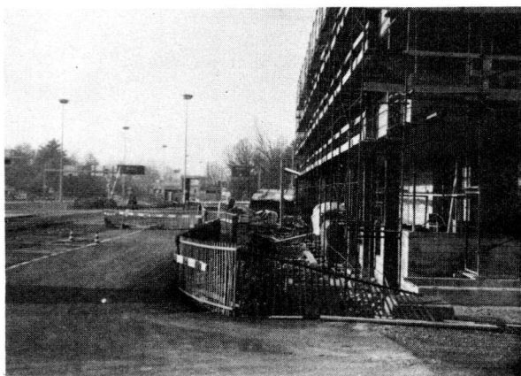
どこも変らぬ工事中 ▷
