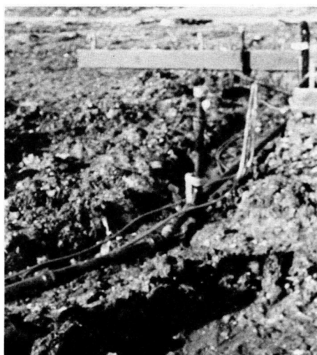
写真-1 水道用銅管、排水用鋳鉄管を床コンクリート打設前に埋設している。端部の養生シールに注意。
