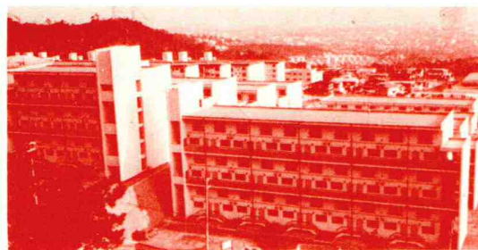
東邦パーライトモルタルPM-C工法(普通タタミ下地)採用の神戸鶴甲団地 (設計 神戸市住宅供給公社 施工 KKK熊谷組他)
