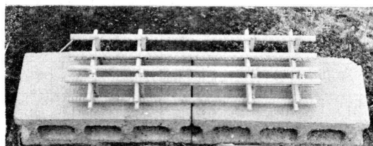
写真-1 亜鉛メッキ鉄筋の組立て
