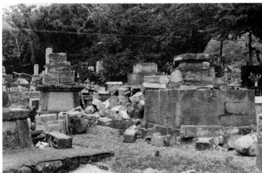
写真-2 「海蔵寺」墓地の破損状況
