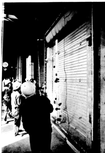
写真-2 No.3試験体 加熱1時間における試験の状況
