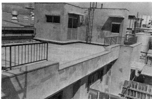
写真－１ 骨材試験棟の外観
