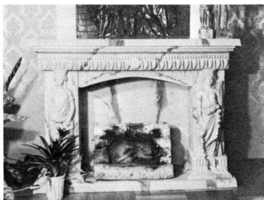
写真-9 シラスバルーン軽石、セメント成形によるマントルピース
