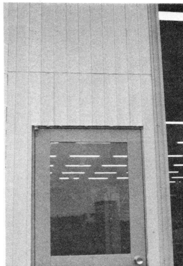
写真-10 シラスバルーンセメント、アスベスト複合建材の押出成形による外壁施工例
