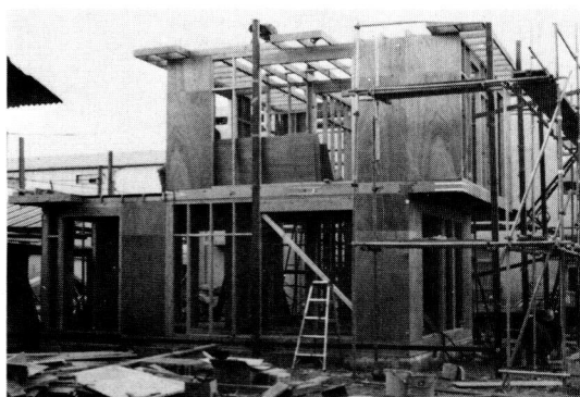
写真-2 試験家屋の建設状況 試験体記号 A-2
