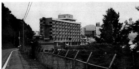
写真-5 洞爺のホテル (昭和40年施工)
