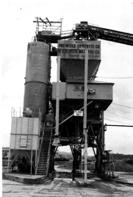
写真-1 10 cu. YD のミキサー車が2台並べるプラント
