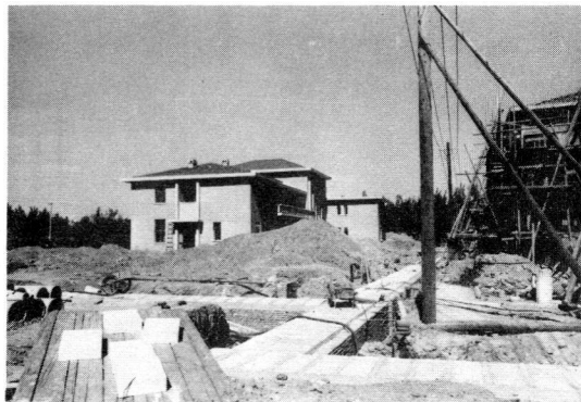
▲大使館工事現場、温水パイプを通す地中溝を 煉瓦とALCで構築中
