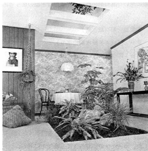
写真-11 青空の見える二重スカイライト
