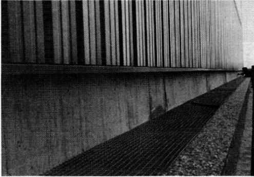
写真-15 体育館の基礎コンクリートは高炉スラグコンクリート（ルクセンブルグ）
