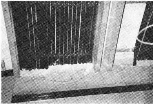
写真-27 Security Pacific Plaza ビルにおける床のグループケーブル貫通部の防火処理
