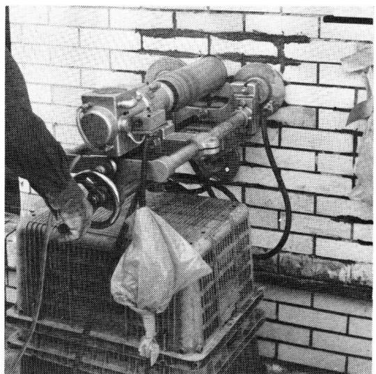
写真-1 外壁の切り込み状況
