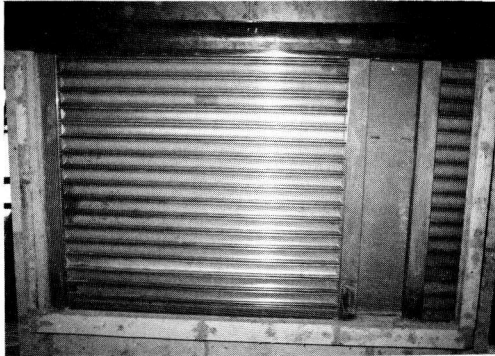
写真-1 加熱前の加熱側表面（屋外側）
