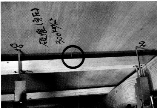
写真-4 破壊状況 荷重300kgf/m 2 (負圧)載荷時 (たる木から野地板が浮き上がった状態)
