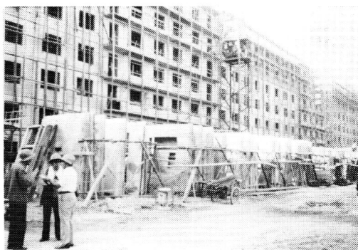
写真-20 北京PCプレハブ工事現場
