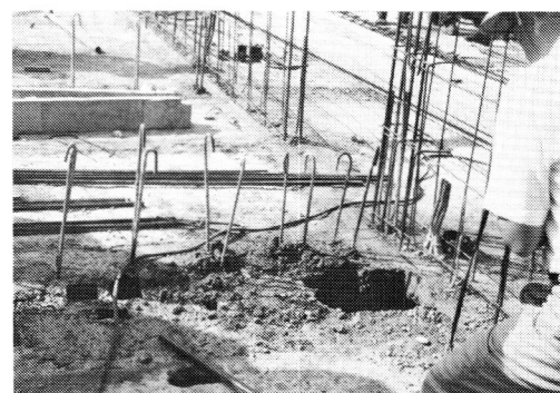
写真-23 同（内壁鉄筋等）
