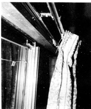
写真-2 カーテンレールによるカーテンの取付状態
