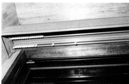
写真-3 カーテンボックスの取付状態
