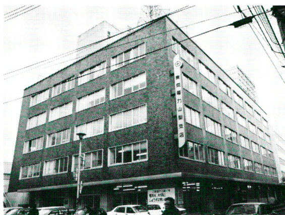
東京電力(株)山梨支店（飛散防止用フィルムC50S施工）
