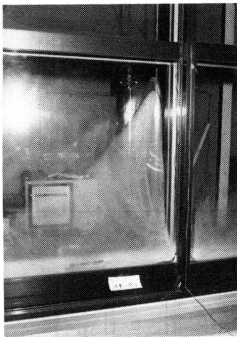
写真-8 外サッシ下部召し合わせ付近外観(外気 - 10℃)
