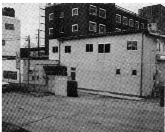
写真-1 建物全景 (2階増築試験棟)
