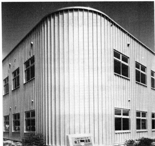
●光洋電子工業株大泉工場／新築屋根・壁工事 設計：株佐野建築研究所 施工：株青木建設
