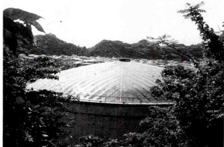
横浜市長沢配水池建家ドーム屋根
