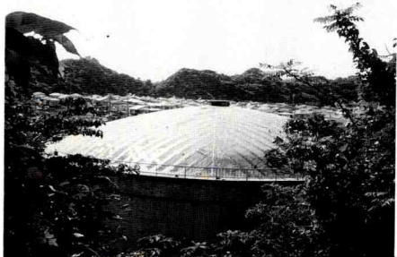
横浜市長沢配水池建家ドーム屋根
