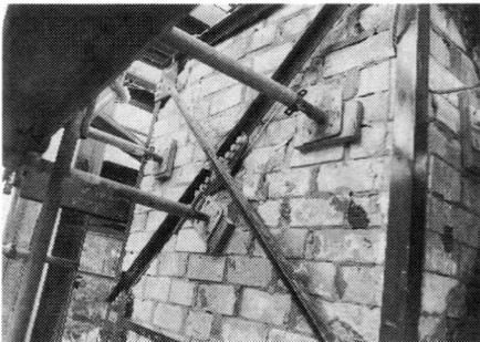
写真-5 補強ジャッキ (煉瓦面)
