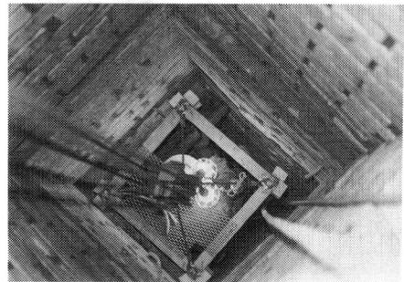
写真-15 煙突内部亀裂補修
