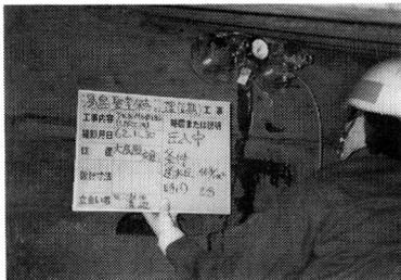
写真-2 モルタルひび割れ部のアルカリ付与剤の圧入
