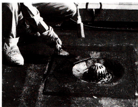
ドレーン廻り
